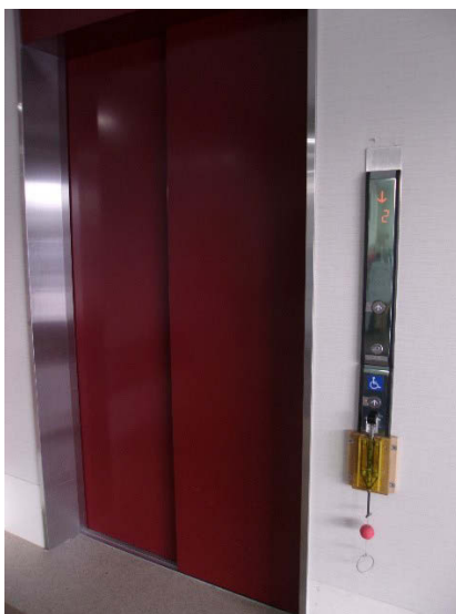
エレベータ外観 (押しボタン下に自助具を設置した様子)
