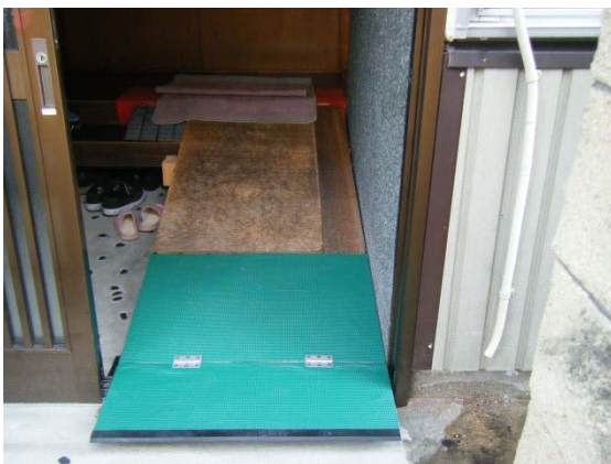
既存スロープに延長して設置した様子
